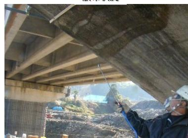
施工完了から養生時間として約24時間の乾燥状態を保つ。
