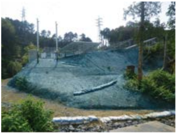
吹付完了 (H30年5月)
