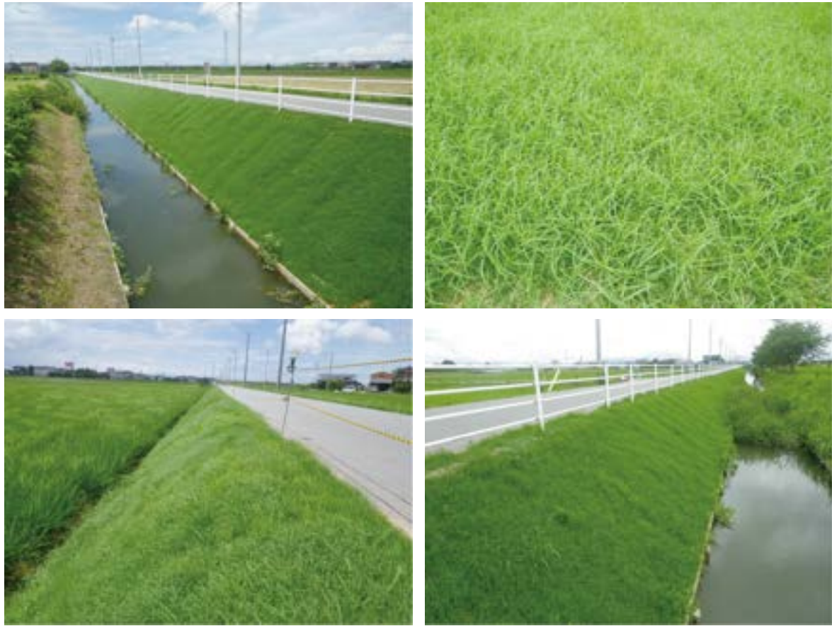
施工後 1ヵ月 (H30年7月)
