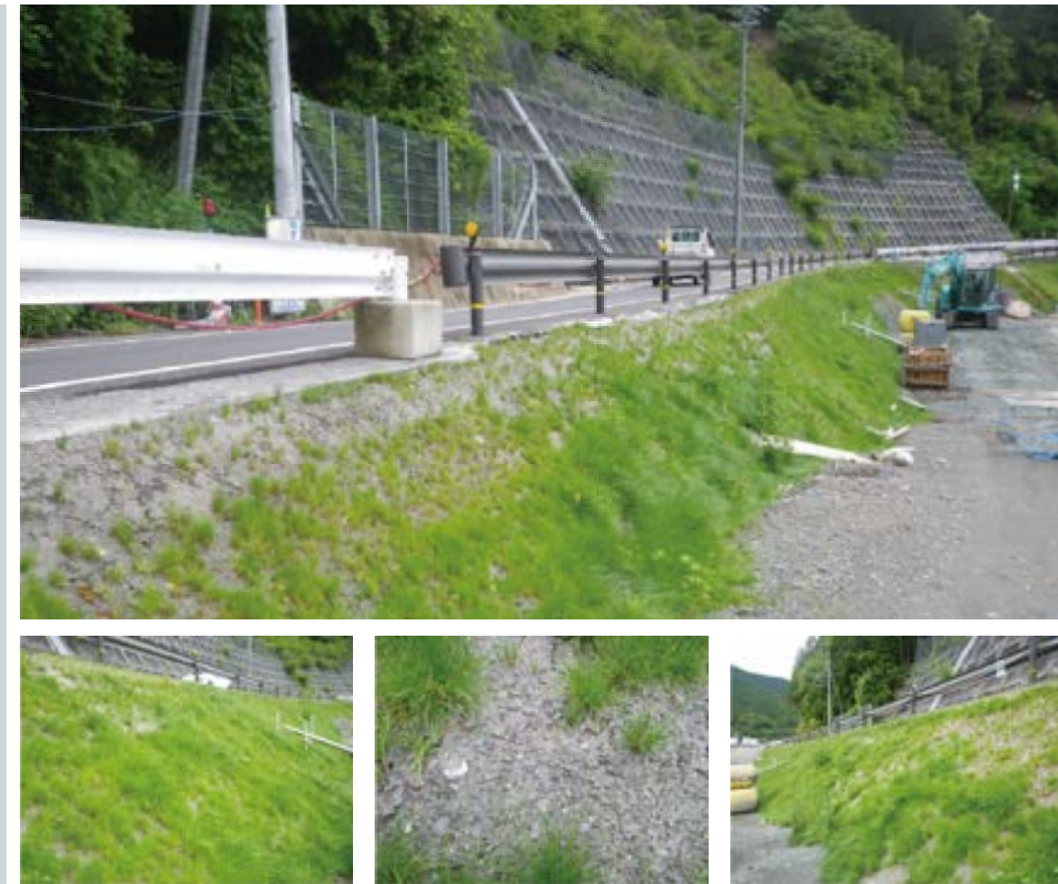
施工後 6ヵ月 (H30年6月)
