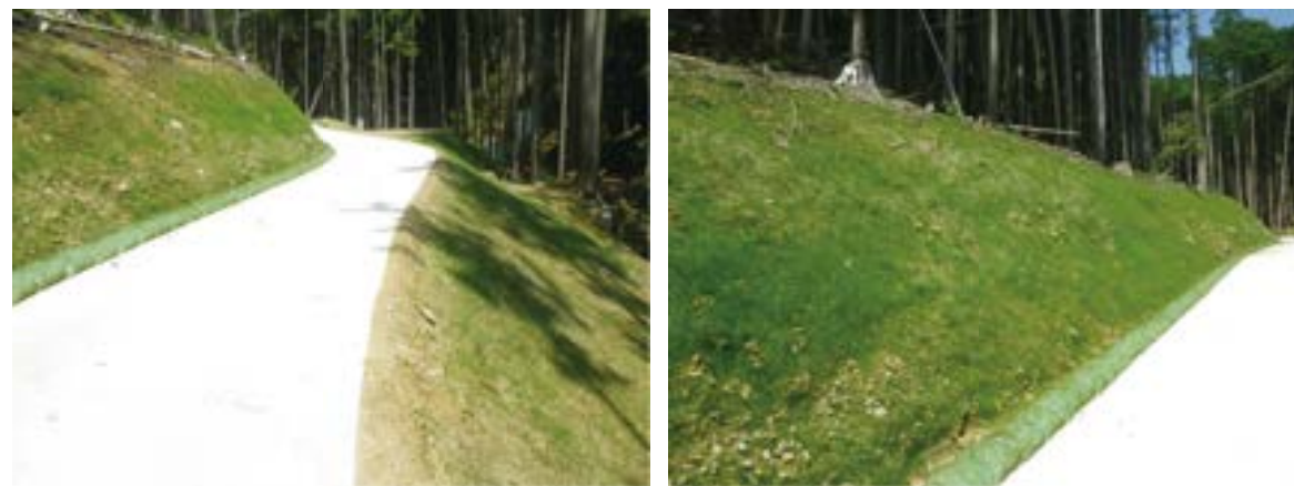
施工後 1ヶ月 (H30年8月)
