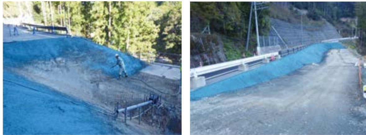
吹付完了 (H29年12月)
