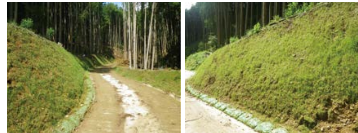
施工後 2ヵ月 (H30年9月)
