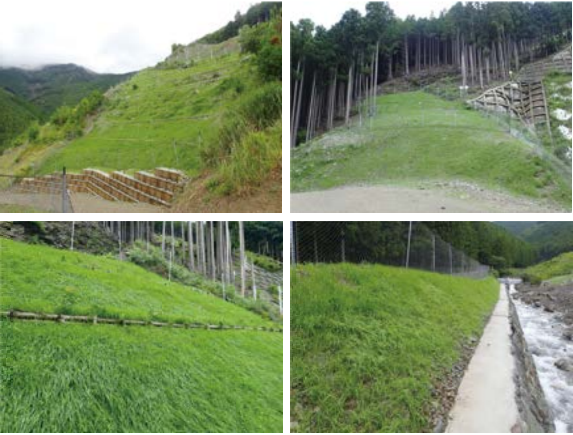
施工後 1ヵ月 (H30年7月)
