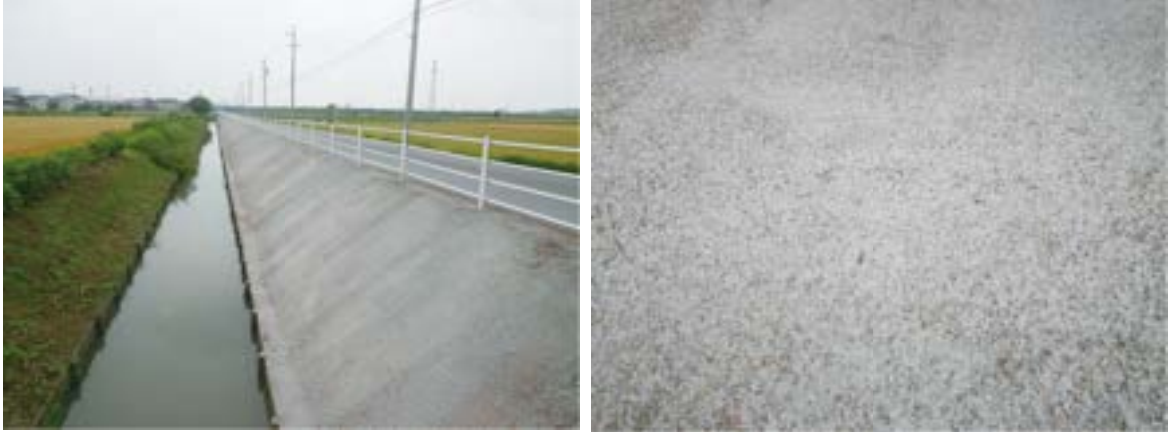
施工後 2週間の 大雨後 ※流出無し
