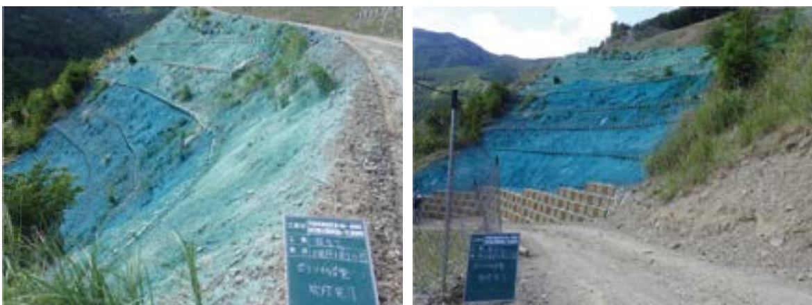
吹付完了 (H30年6月)
