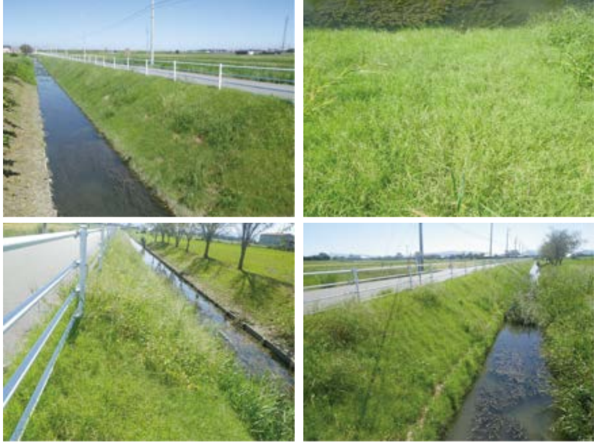
施工後 4ヵ月 (H30年10月)
