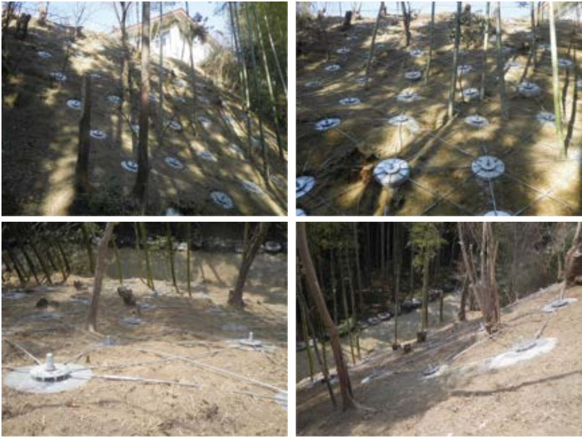
樹間施工で行ったプレストネット工の裸地法面。
