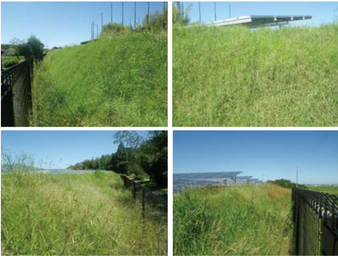
施工後 4ヵ月 (H30年10月)
