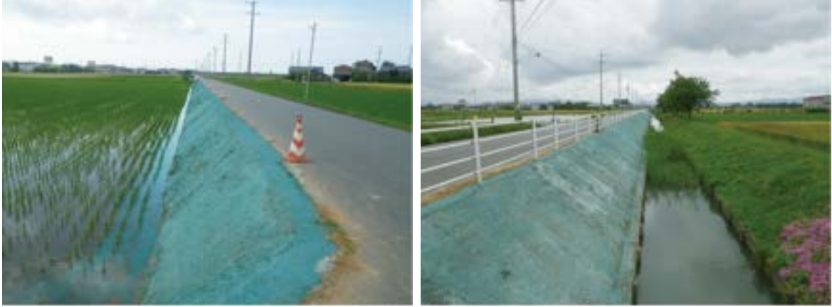
吹付完了 (H30年6月)
