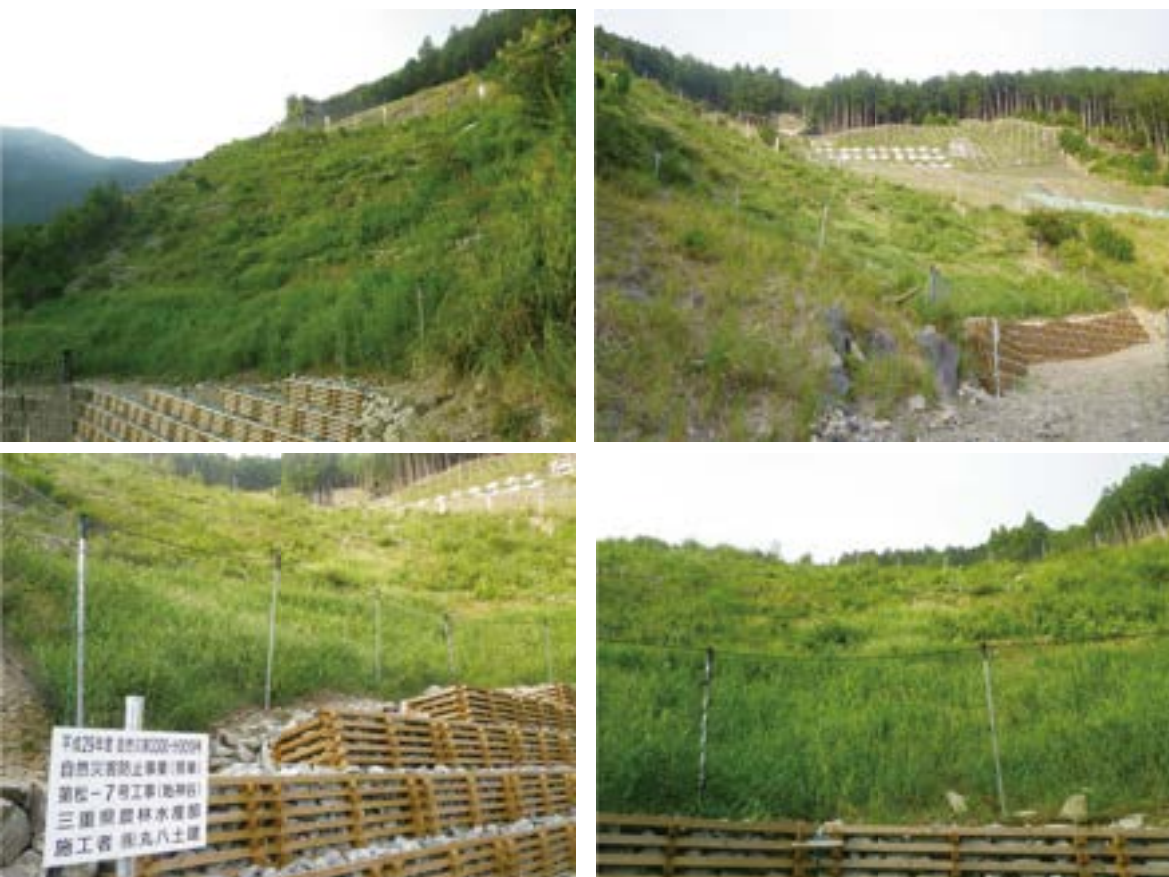
施工後 3ヵ月 (H30年9月)
