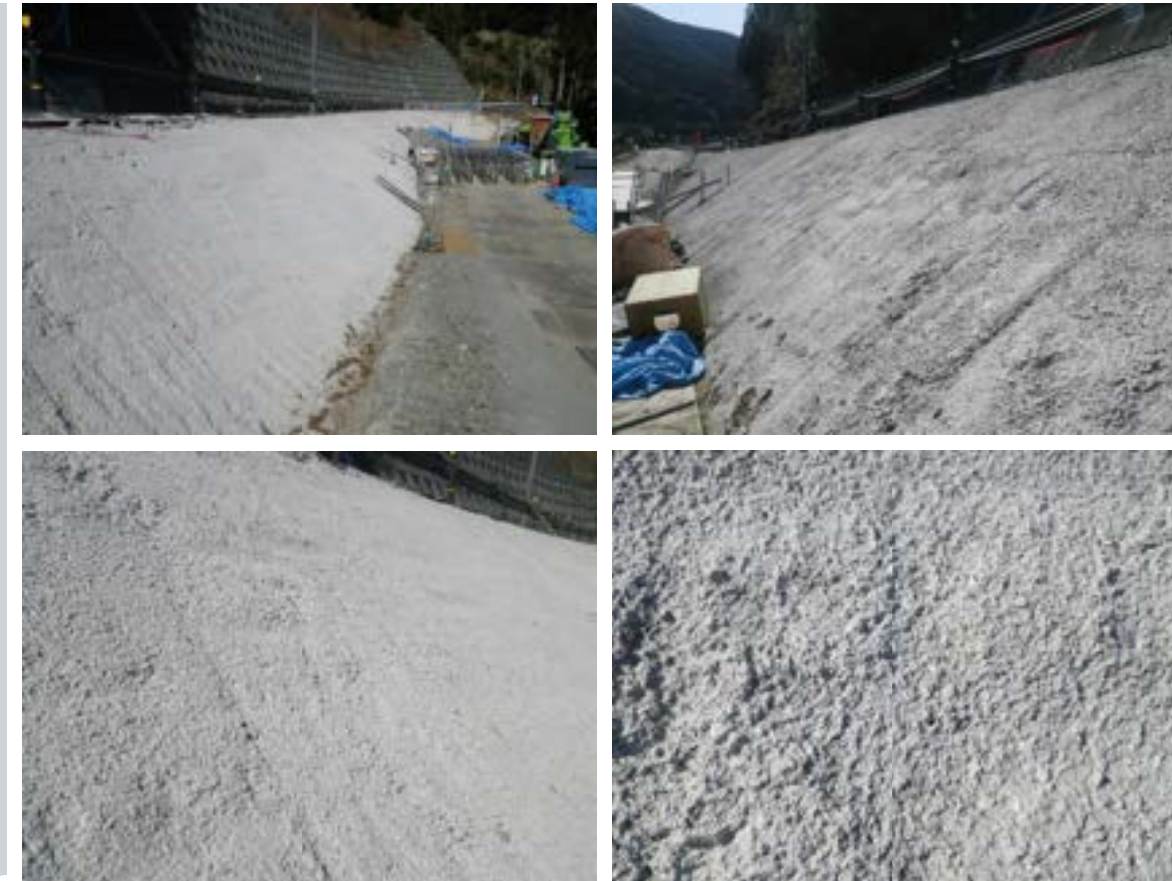
施工後 3ヶ月 (H30年3月)
