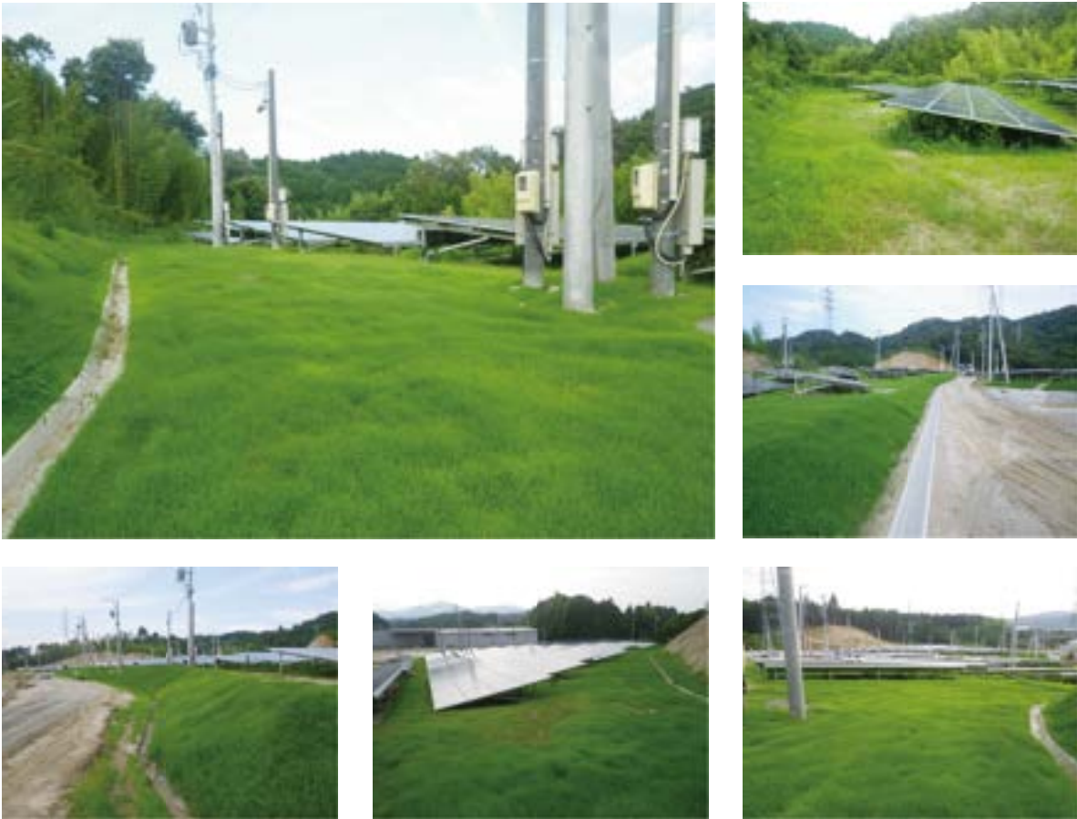
施工時期が良かった為、約1ヵ月で全面緑化しました。
