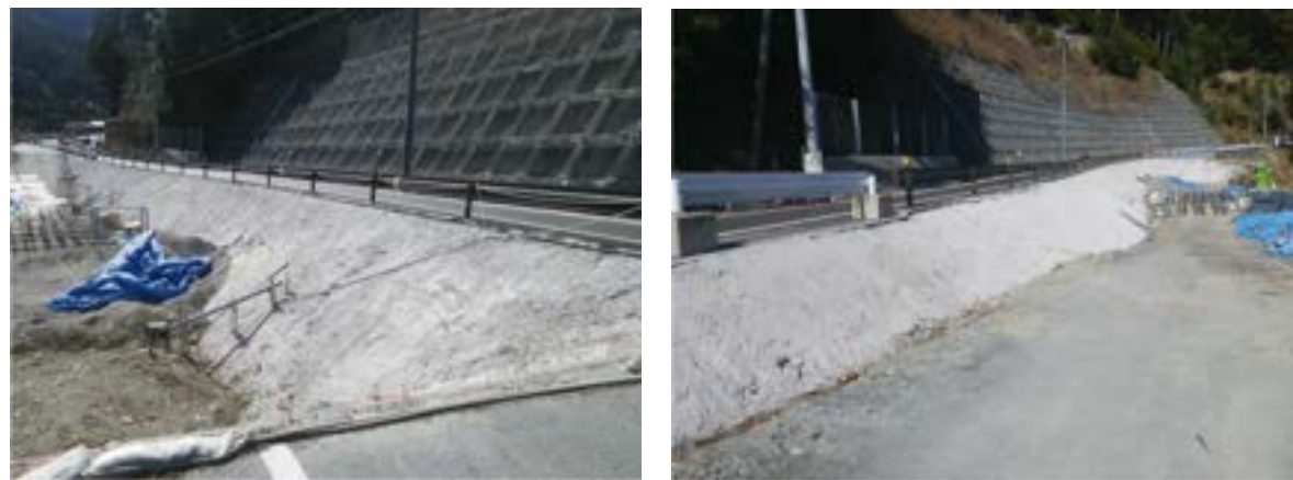
施工後 3ヶ月 (H30年3月)
