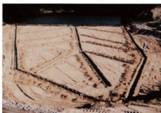
盛土下部暗渠排水
