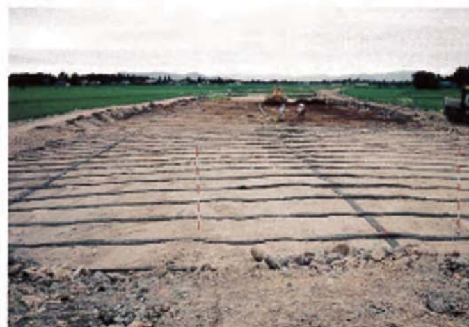
軟弱地盤の圧密水の排水
