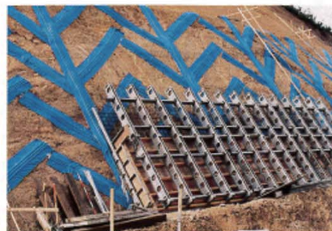
のり面排水および構造物裏込排水
