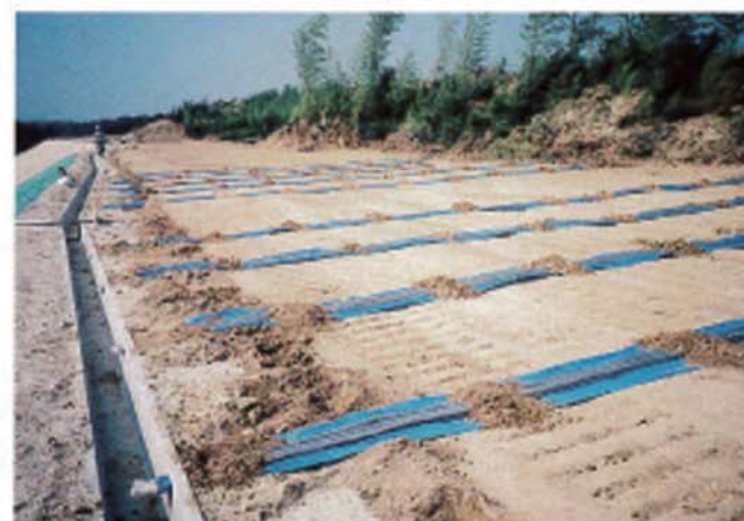
盛土内水平排水
