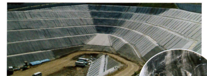
従来工法との比較 ラス金網敷しモルタル吹付した例(参考)
