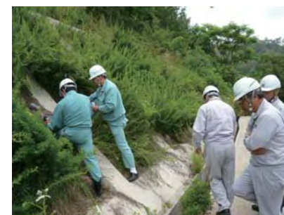
■供用中鉄筋挿入工の長さ測定
