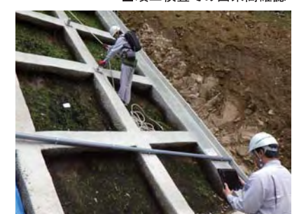
■施工後の出来形管理
