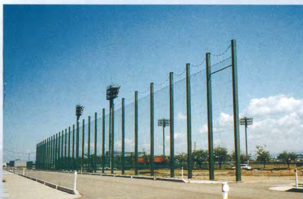
ネットフェンス
