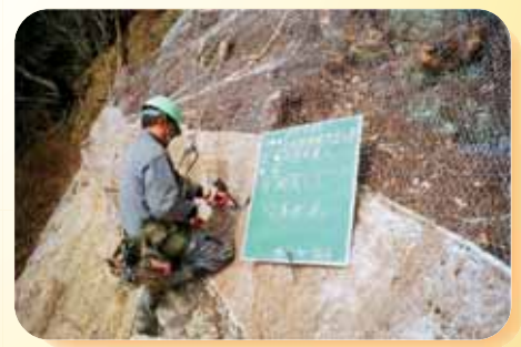
⑤ アンカーピン打設
