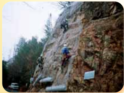
③ 亀甲金網張り工
