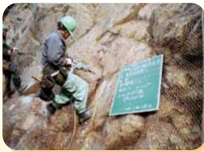
④ 削孔状況
