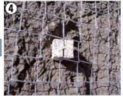
④ 設置完了
