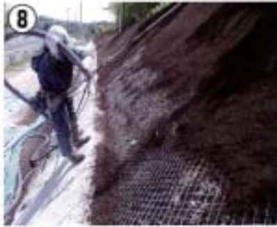
⑧ 吹付状況
