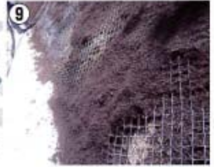
⑨ 吹付完了
