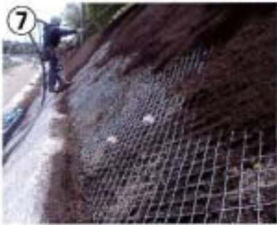
⑦ 設置完了全景
