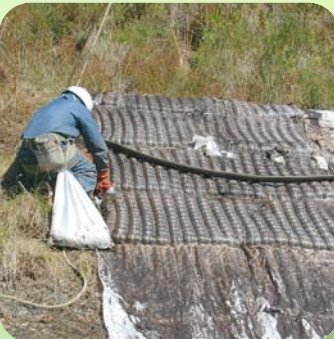
2. 植生基材注入
