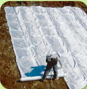
1. マットの敷設
