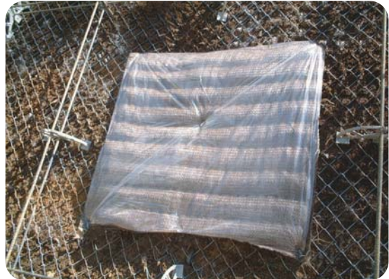
イーザーマット (t=3cm)。 植生基材吹付工 (t=5cm) と同等。
