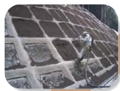
8. 枠モルタル吹付完了
