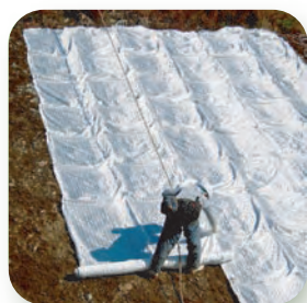
1. マットの敷設
